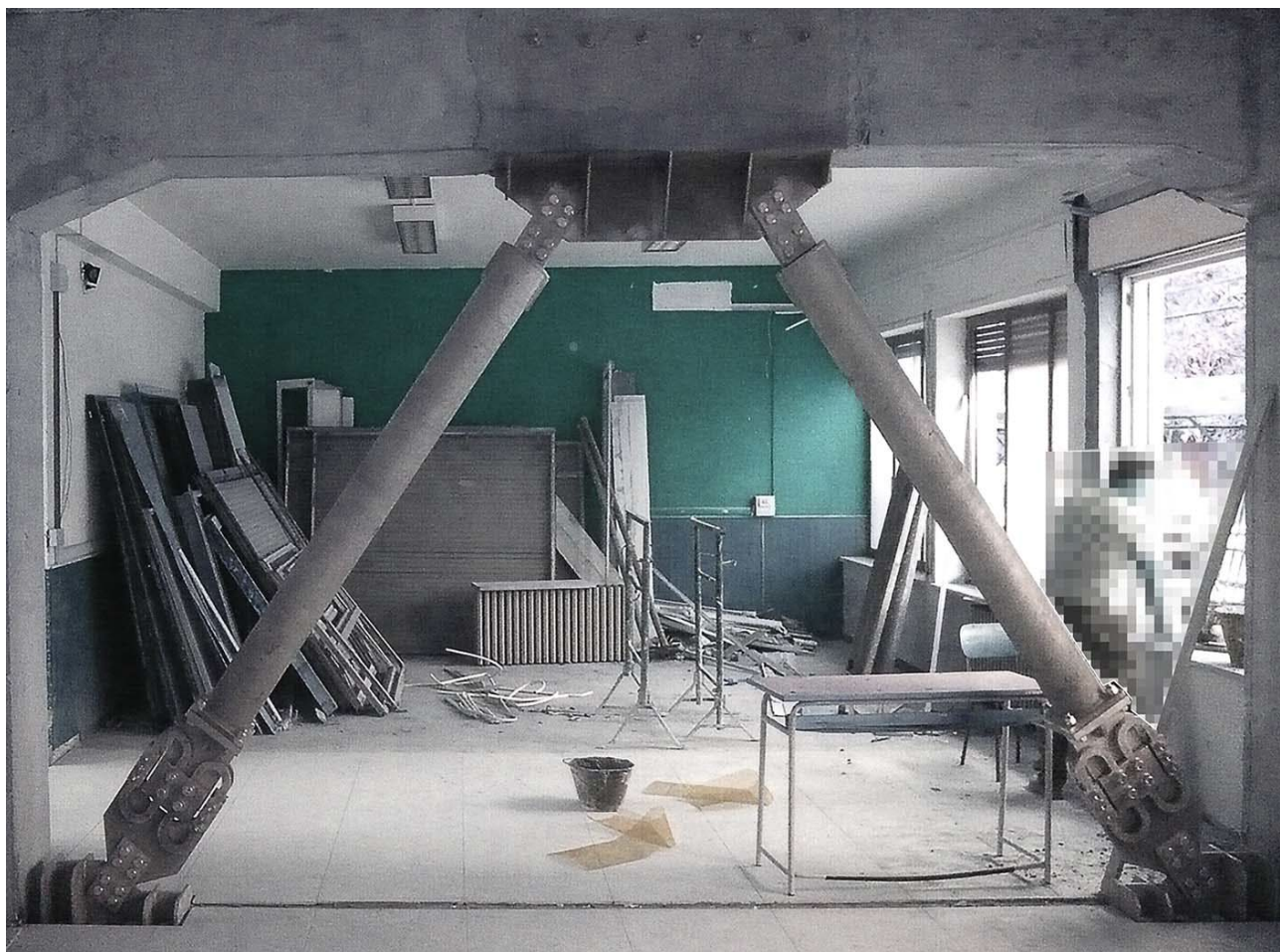
Installazione di controventi dissipativi
