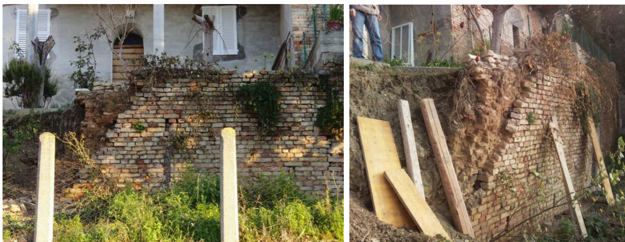
Fig. 7 – La porzione di mura interessata dal crollo e lateralmente quella in evidente stato di deformazione. In evidenza sul lembo della parte crollata la sezione muraria.
