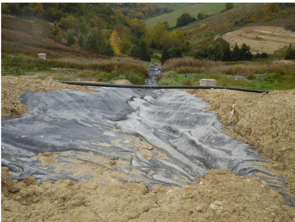
*Figura 79: Foto 4-Canaletta superficiale principale per raccolta acque meteoriche*
