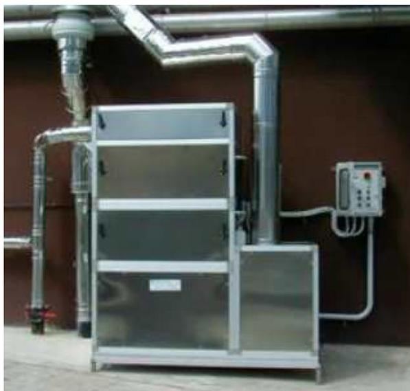
*Figura 123: Esempio di Filtro a Zeolite*
