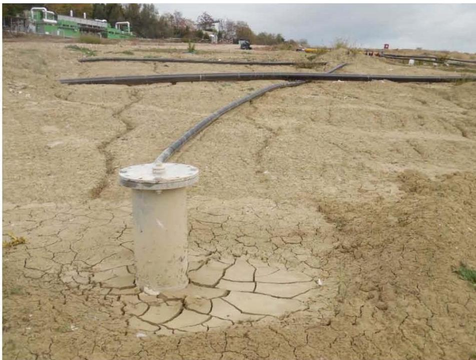
*Figura 118: Pozzo biogas*
