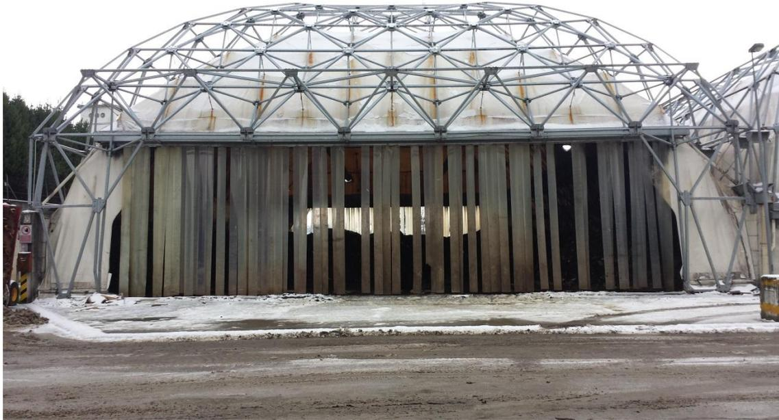
*Figura 99: Tensostruttura utilizzata per lo scarico e lo stoccaggio*
