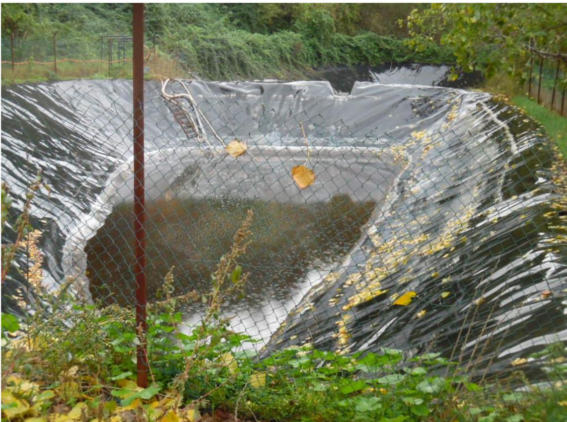
*Figura 77: Foto 2-Sistema di stoccaggio percolato con due laghetti*
