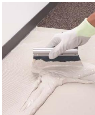
Su supporto adeguatamente preparato, procedere alla stesura dell'adesivo per l'incollaggio dei teli fonoisolanti
