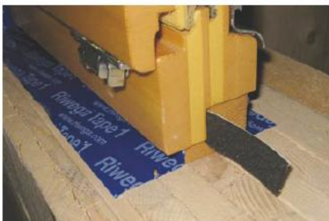
GAE UNIVERSAL tra serramento e falsotelaio
