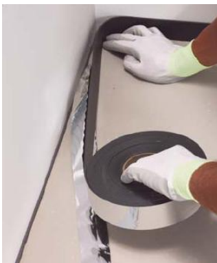
Applicare lungo il perimetro del locale il nastro adesivizzato Mapesonic Strip
