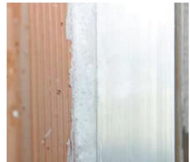
USB Foam tra muratura e falso telaio
