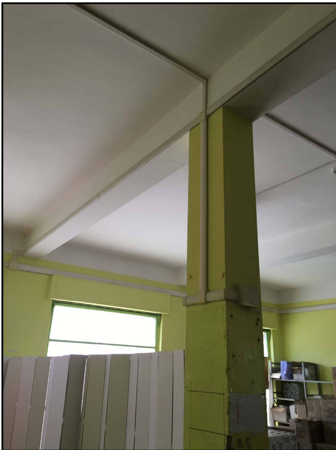
FOTO 5 - Vista interna del piano terra del corpo principale con la struttura intelaiata in c.a. con pilastri 30x40 e travi ribassate 30x65 disposti a formare telai paralleli.
