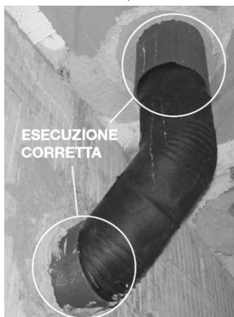
Figura 10.5 - A) disaccoppiamento realizzato con guaina isolante Geberit.
