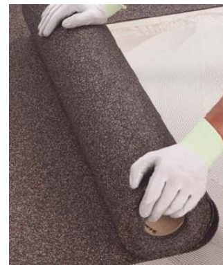
Distendere i rotoli di Mapesonic CR lungo le superfici interessate
