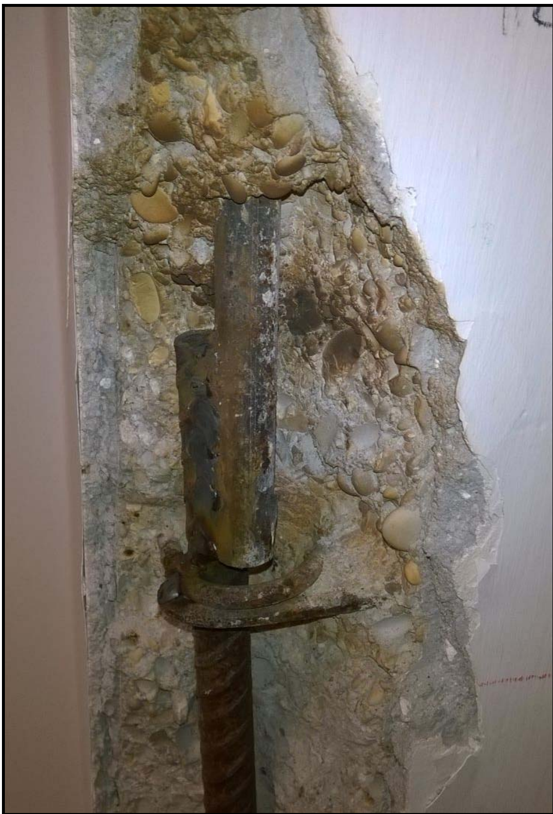
FOTO 8 - Vista di un pilastro da cui è stato prelevato un campione di armatura; la barra originaria è quella liscia da 16 mm. cui è stato saldato lo spezzone ad aderenza migliorata per ripristinarne la continuità; si nota che la staffa ha gli estremi ripiegati all'interno della sezione, e pertanto può essere ritenuta idonea ad assicurare una modesta azione di confinamento delle armature, pur essendo disposta con un passo eccessivo (circa 25 cm.) rispetto alle previsioni delle norme vigenti.
