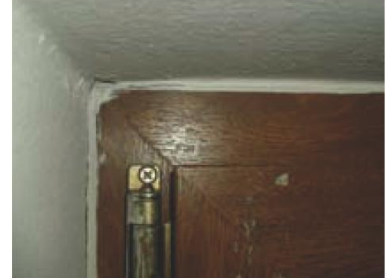
Distacco del silicone dall'intonaco
