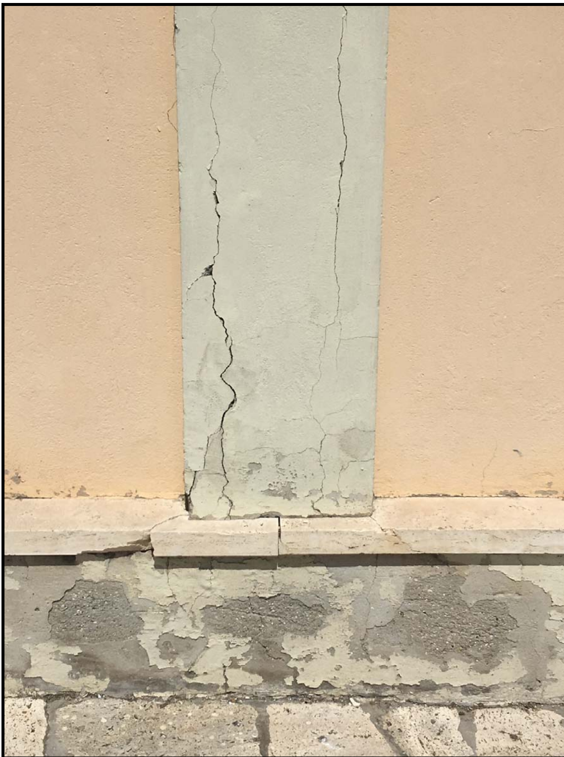
FOTO 6 – La base dei pilastri del prospetto su piazza Dante del corpo principale è interessata da problemi non strutturali di rottura dei relativi spigoli per rigonfiamento delle armature.
