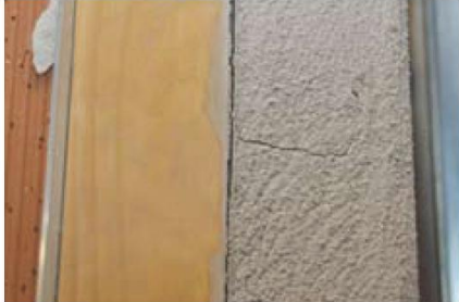
Fessura tra intonaco e falsotelaio
