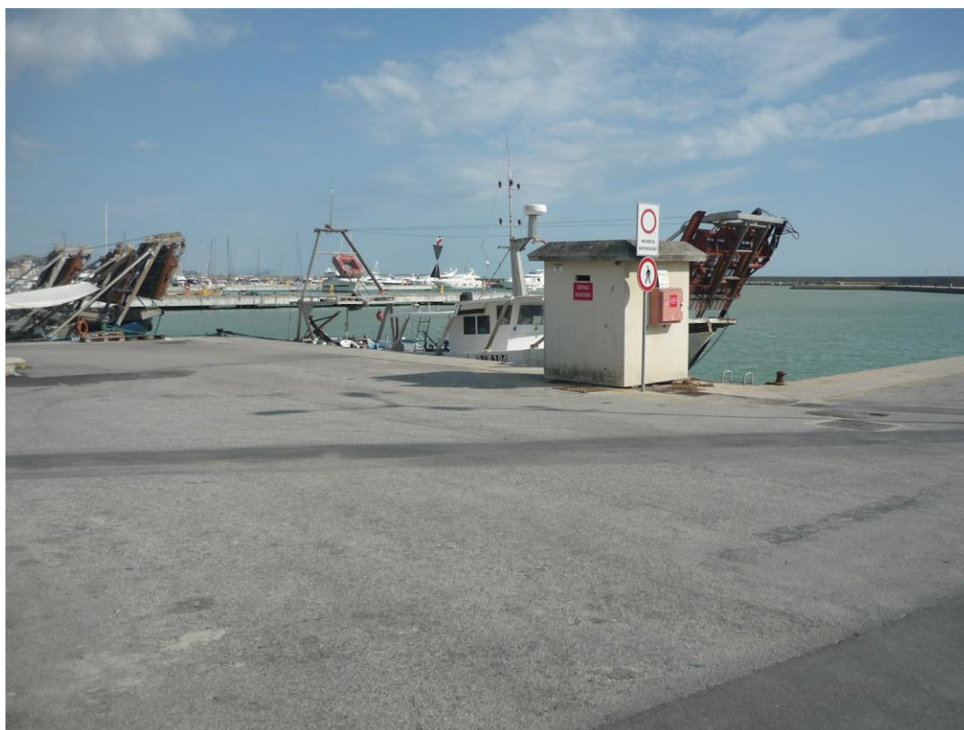
FOTO 9 – BOX PREFABBRICATO IMPIANTO ANTINCENDIO
