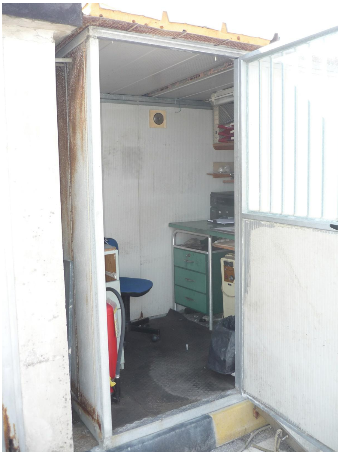
FOTO 8 – BOX PREFABBRICATO N. 2
