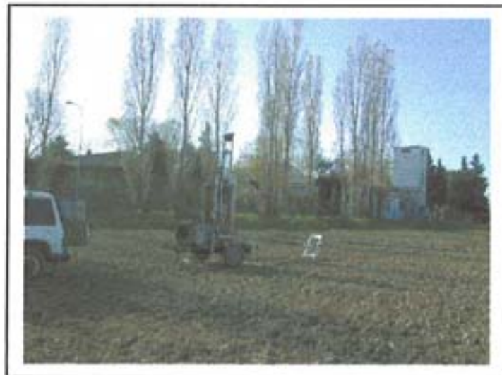
Foto 2 _Realizzazione prova penetrometrica DPSH n°2 e panoramica dell'impianto esistente.
