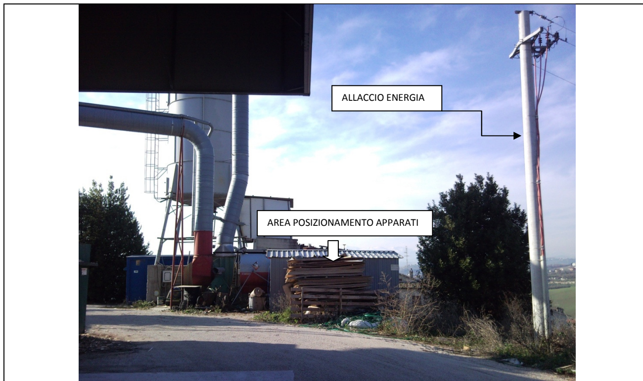
FOTO N. 1 - Vista del silos e del luogo dove verrà posizionato il sito
