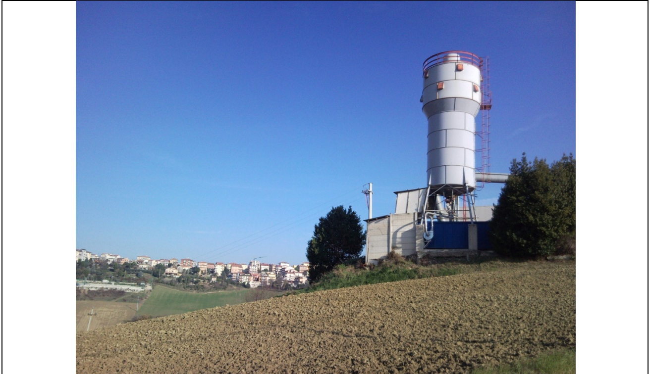
FOTO N.3 - Vista del silos dalla strada comunale C.da Parete
