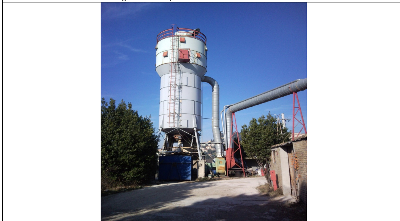
FOTO N. 2 - Vista del silos dove verranno posizionate antenne e parabole
