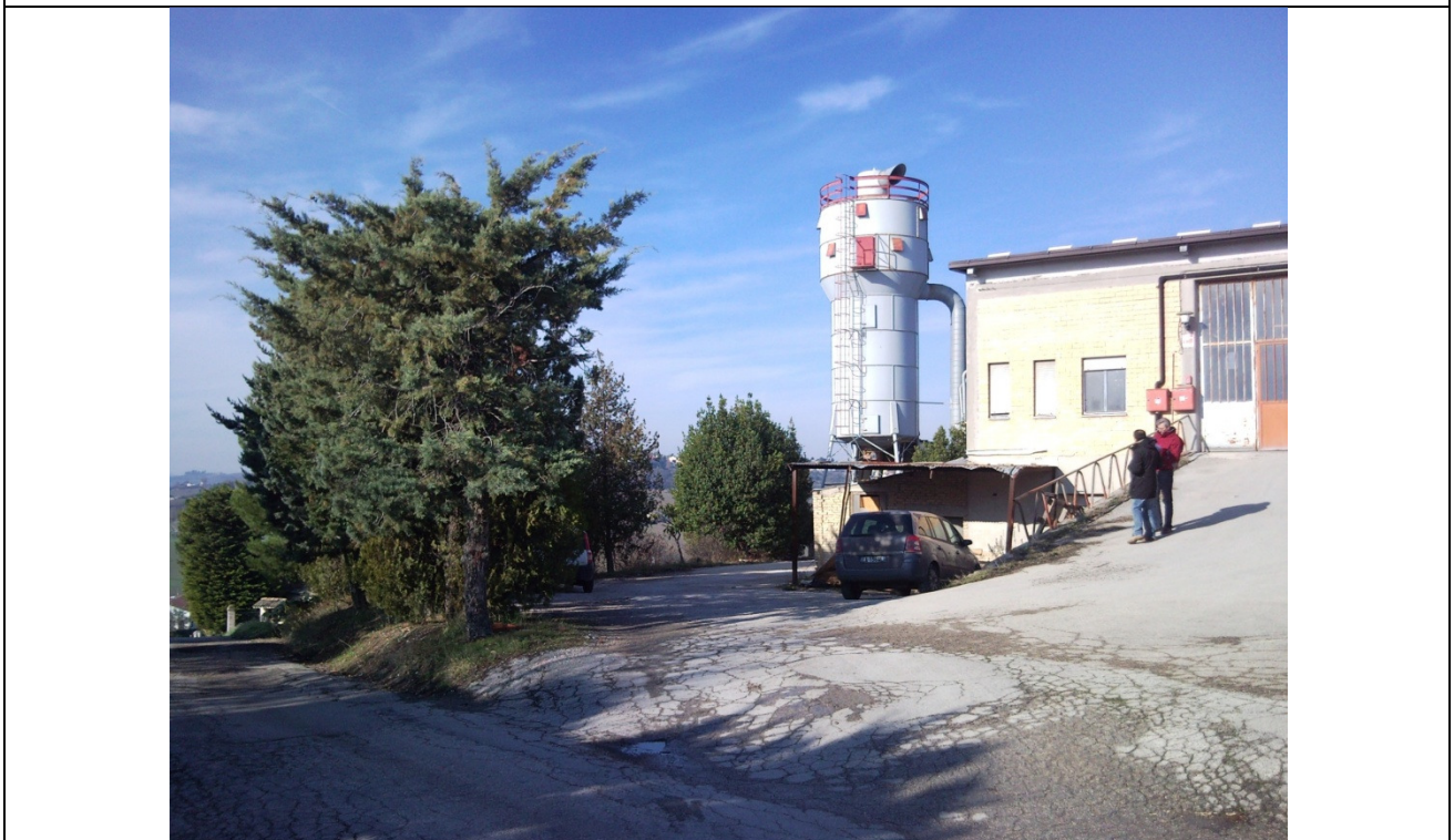
FOTO N.4 - Vista del silos dalla strada comunale C.da Parete
