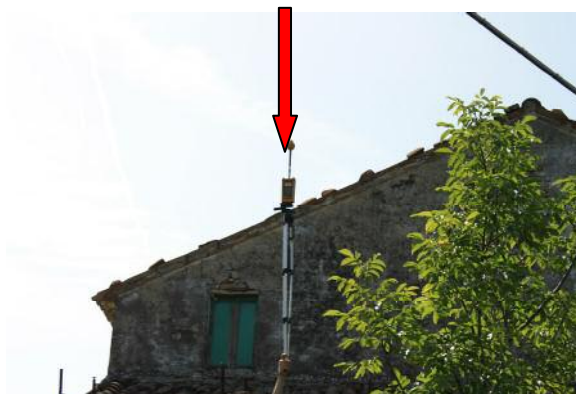
Punto di controllo D
