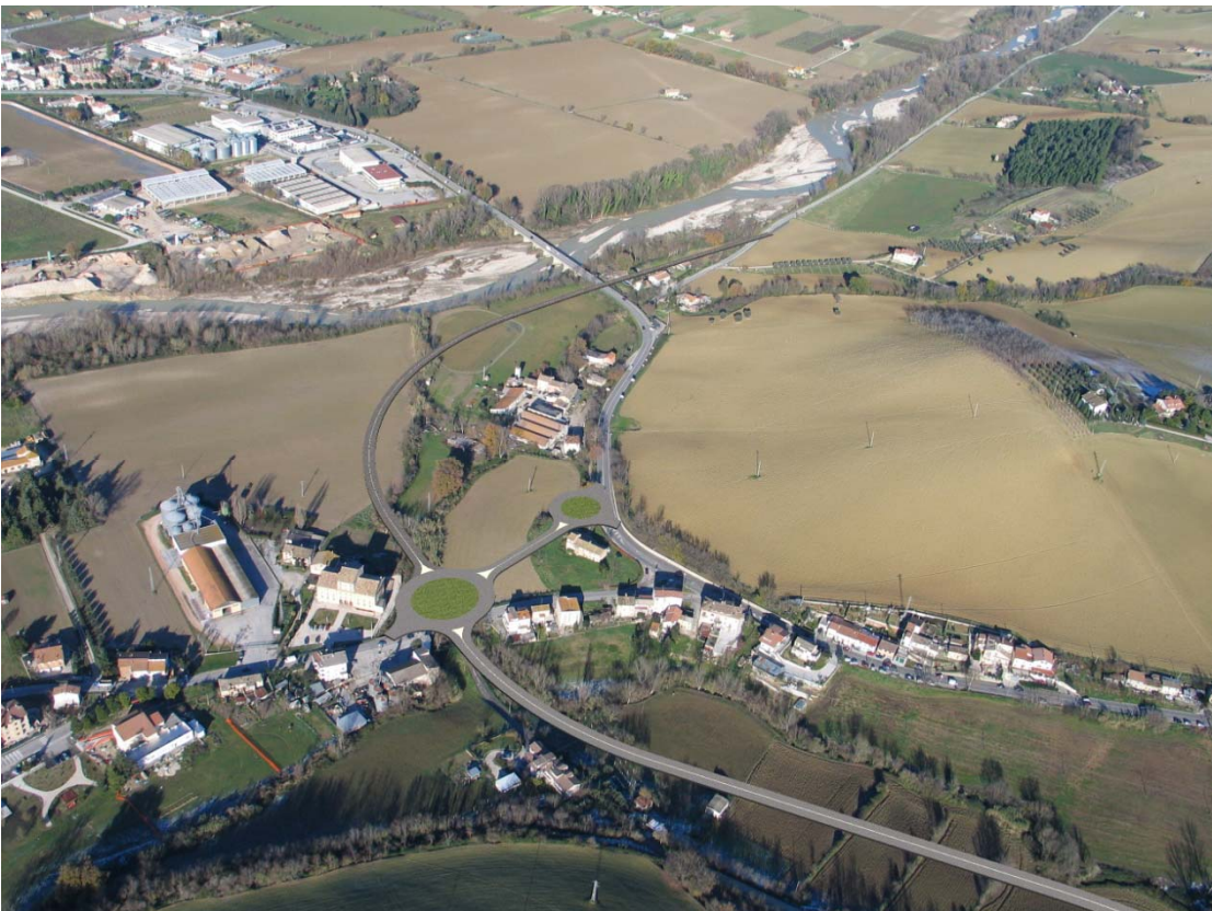
Tratto centrale e terminale della Bretella – rotatorie e allaccio alla SP 204 Lungotenna
