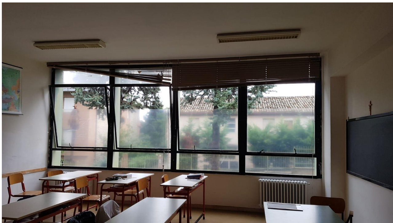
Figura 5 – Infissi esterni da sostituire (aula piano secondo del corpo storico - prospetto sud)
