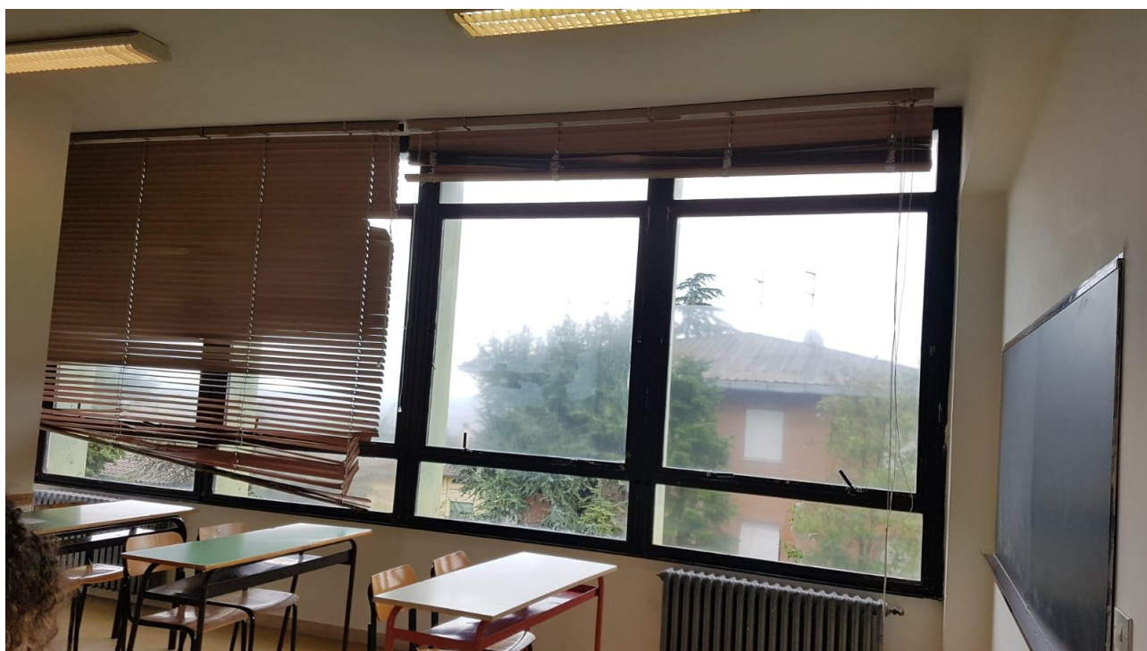
Figura 2 – Infissi esterni da sostituire (aula piano secondo del corpo storico - prospetto sud)
