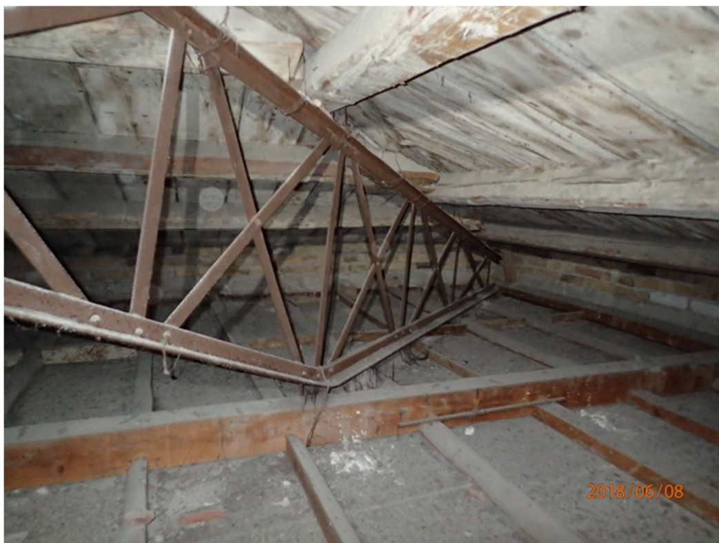
Struttura di copertura esistente oggetto di rifacimento - Trave reticolare in acciaio
