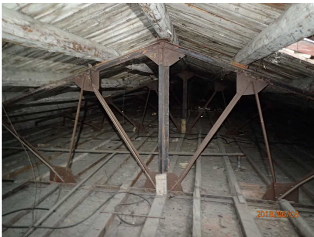
Struttura di copertura esistente oggetto di rifacimento - Capriata in acciaio
