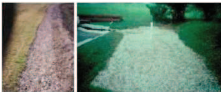
Foto 2 – esempi di trincee infiltranti (tratte dalle linee guida regionali scheda D7: gallerie di infiltrazione)
