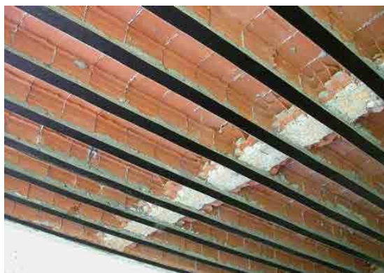
Fig. 6 - rinforzi taglio flessione di solaio in latero cemento
