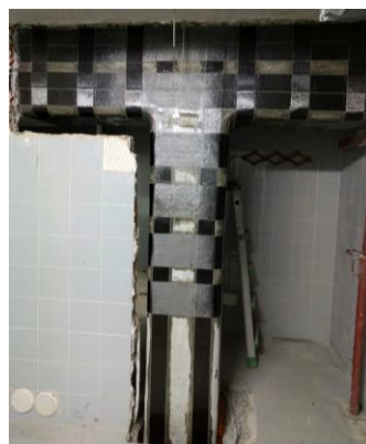
Fig. 2 -Rinforzo nodo-trave pilastro
