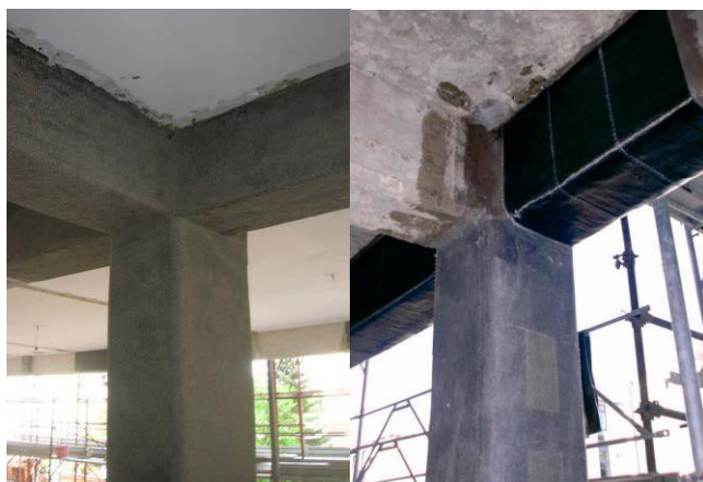
Fig. 3 - rinforzi per modificare il meccanismo di rottura
