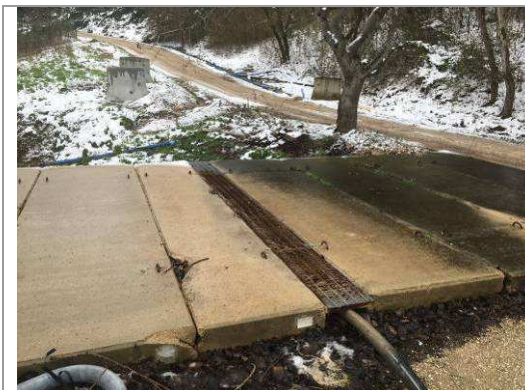
Figura 22 – Blocchi in Calcestruzzo della Vasca di Sollevamento
