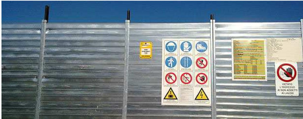
**Figura 8 Tipologia recinzione di cantiere**
