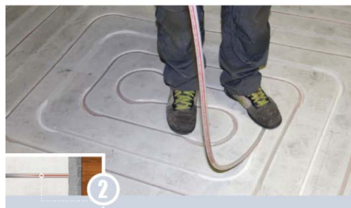
Installazione tubazione
