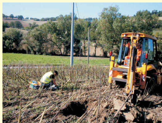
SCAVO S 5 CAMPIONE C 1 tratta o segmento stradale a morfologia pianeggiante con struttura di progetto a raso/leggero rilevato
