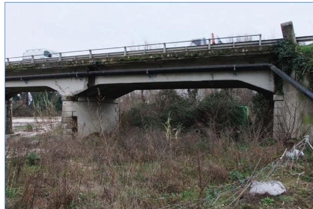
Foto B: Vista del ponte da Ovest con particolare della spalla dx
