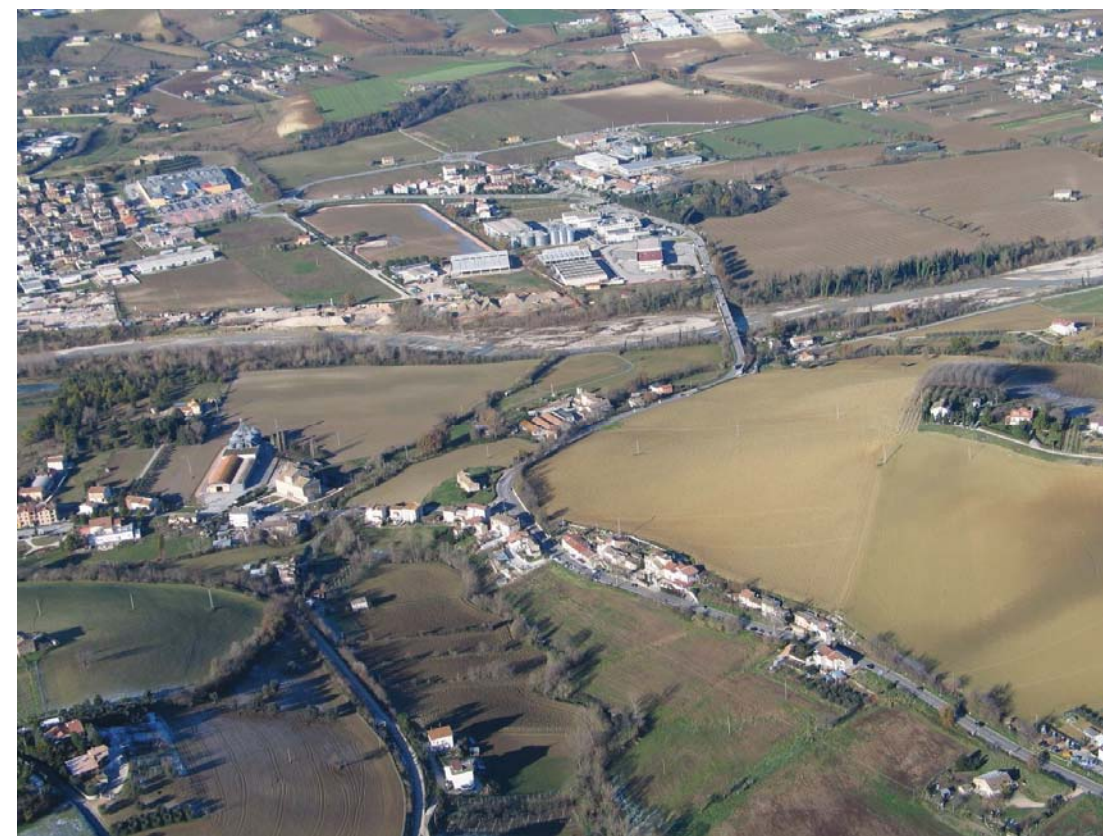
Figura 2 Ambito territoriale di riferimento. Vista panoramica verso nord
