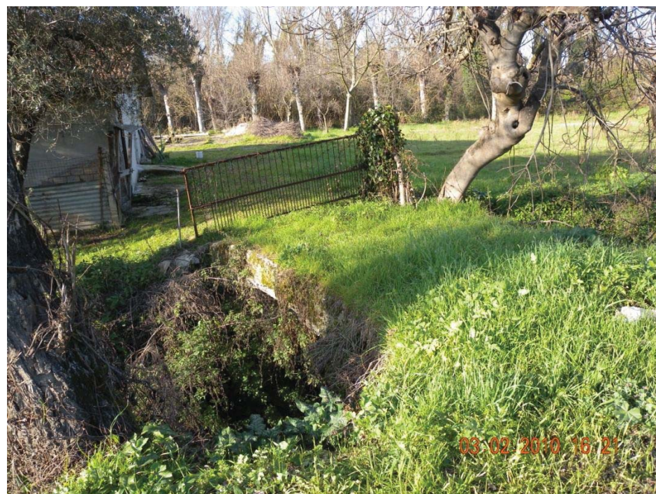
Figura 21, INCROCIO MOLINI, TENNA, BORE di TENNA
