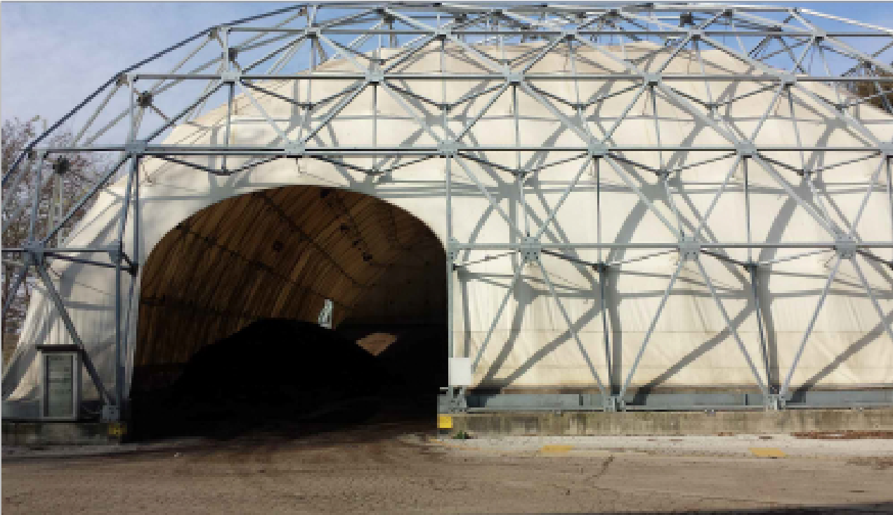
D11-D12: Porta edificio di ossidazione biomassa con "para aria"
