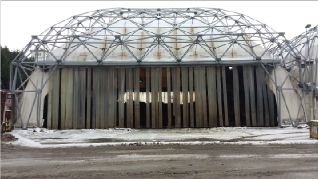
D3-D4: Porta edificio di ossidazione biomassa con "para aria"
