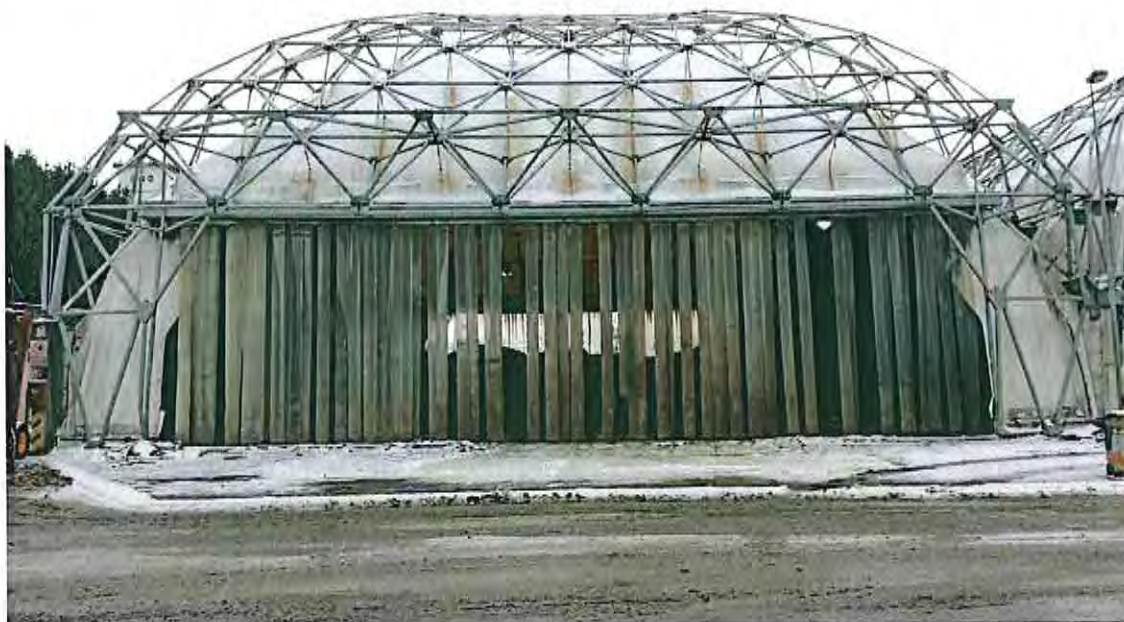
Figura 97: Tensostruttura utilizzata per la bioossidazione della FORSU
