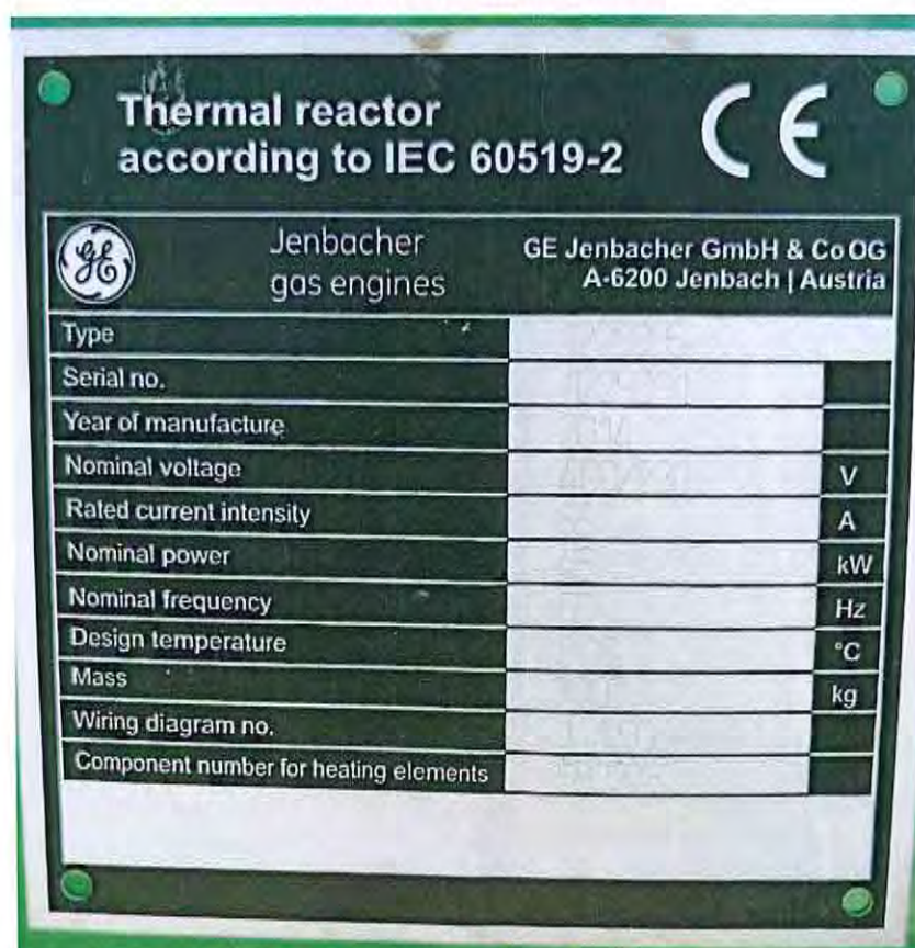
Figura 101:Post Combustore 1
